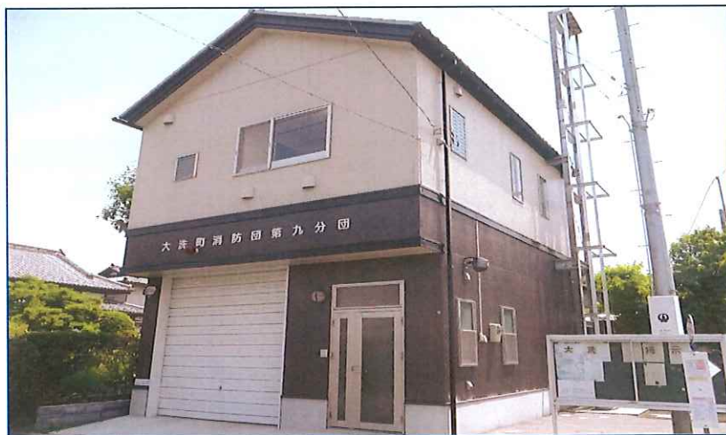
第九分団詰所 平成19年3月竣工
