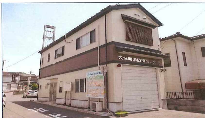
第二分団詰所 平成18年3月竣工
