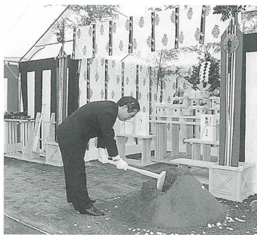
▲工事の安全を願いクワ入れする小谷町長
