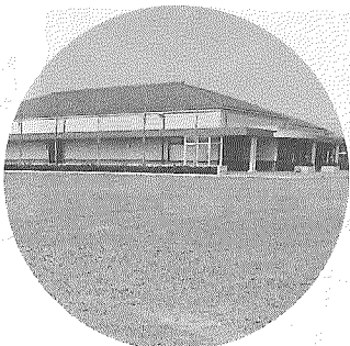
駐車場の整備
