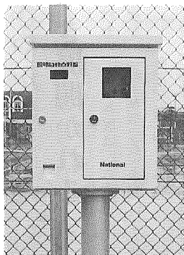
▲コイン式照明点灯盤
