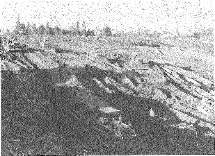
総合運動公園造成工事
