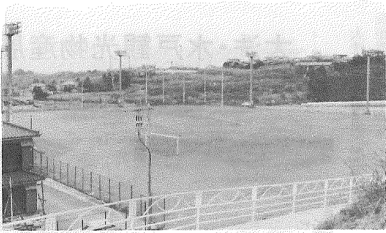
▶ 屋外運動場夜間照明施設
