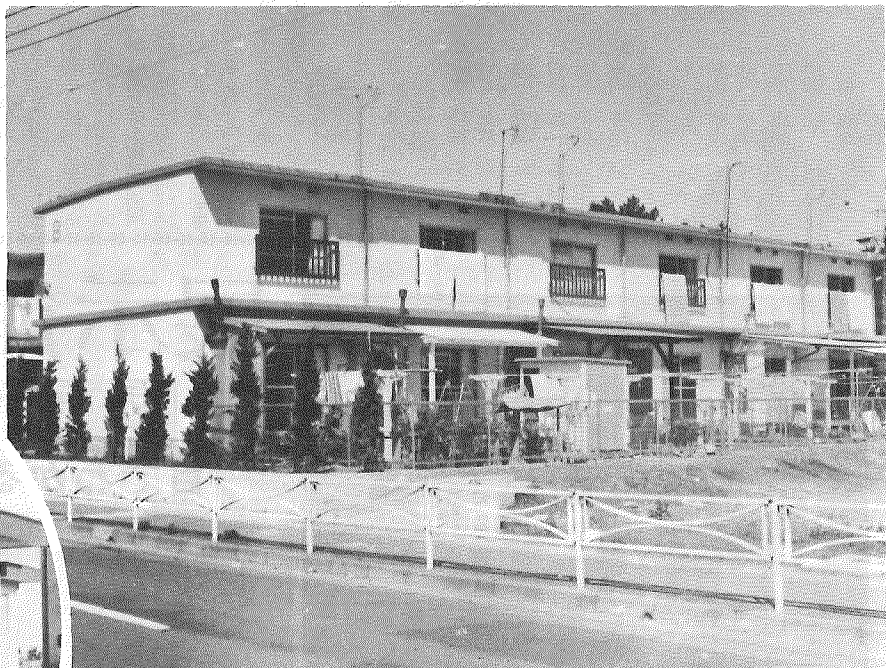
▲町営松ヶ丘住宅
