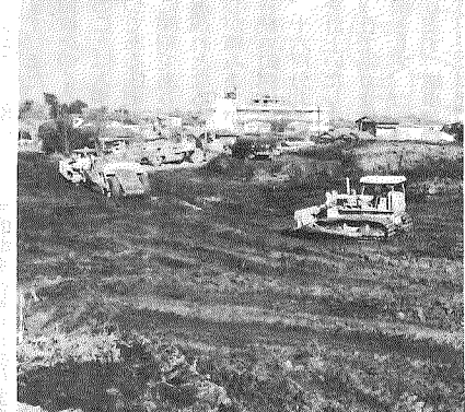
桜道の工事風景
