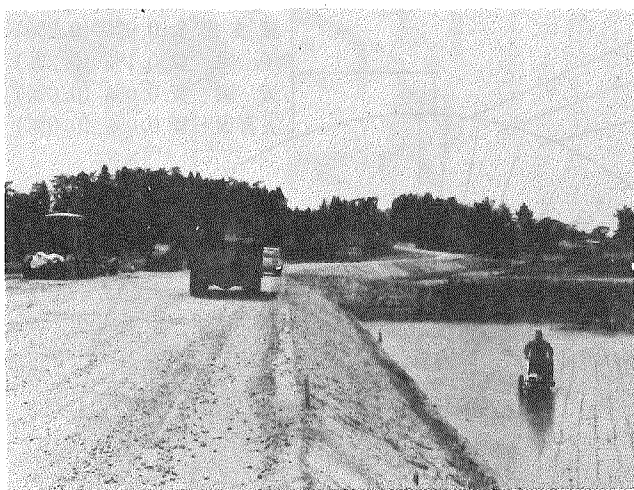
建設中の農免道路
