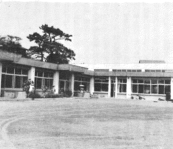
▲防音工事完成後の第一保育所
