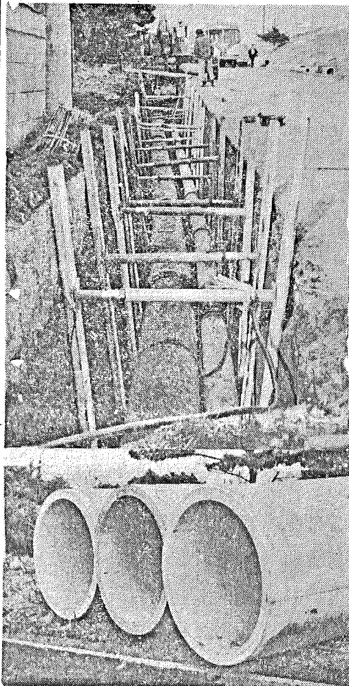
⑤ 上水道新幹線布設工事 (国道51号線南中学校付近) ⑥ 国道51号線の横断地中貫孔工事用ヒューム管
