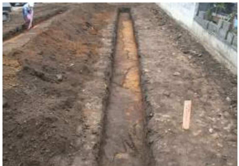
写真25 第2号トレンチ全景（北東から撮影）
