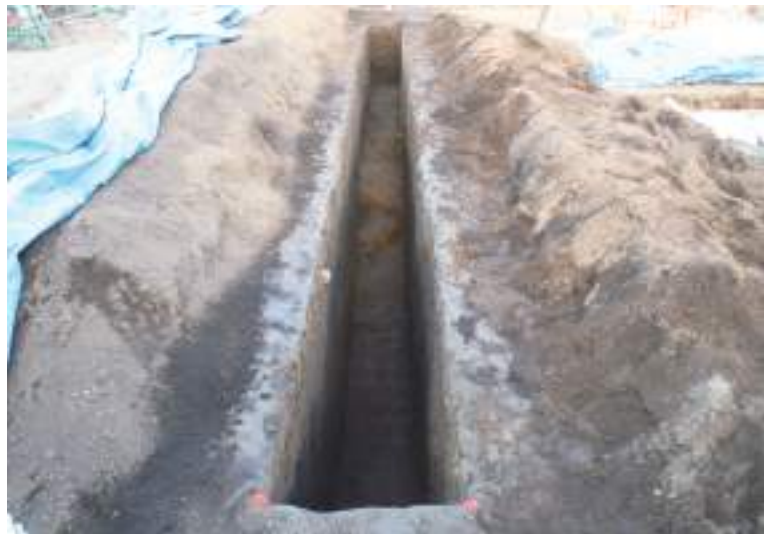
写真44 第1号トレンチ全景（南西から撮影）
