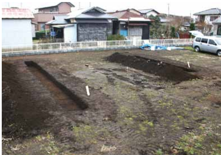
写真5 調査区全景（東から撮影）
