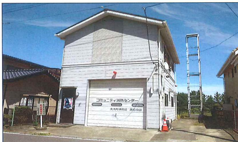
第六分団詰所 平成6年3月竣工
