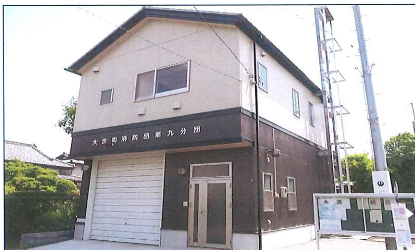
第九分団詰所 平成19年3月竣工
