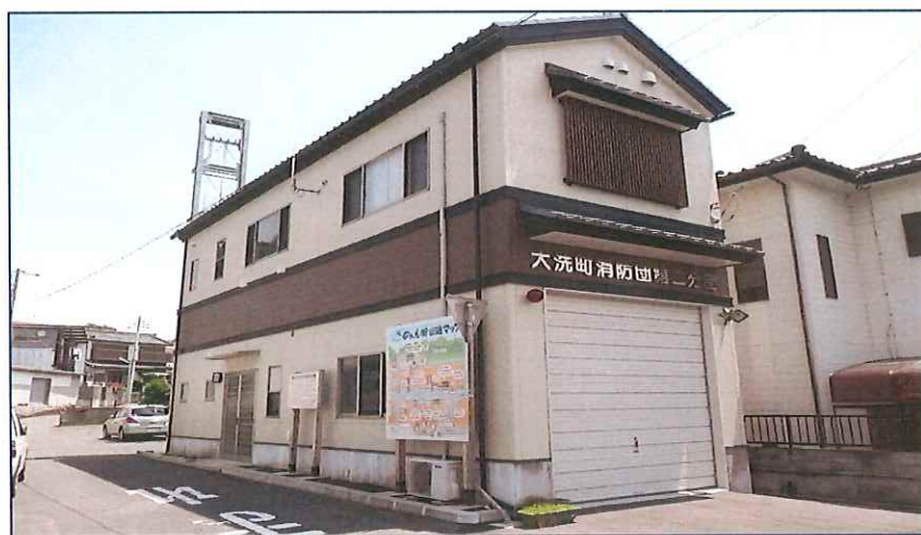
第二分団詰所 平成18年3月竣工
