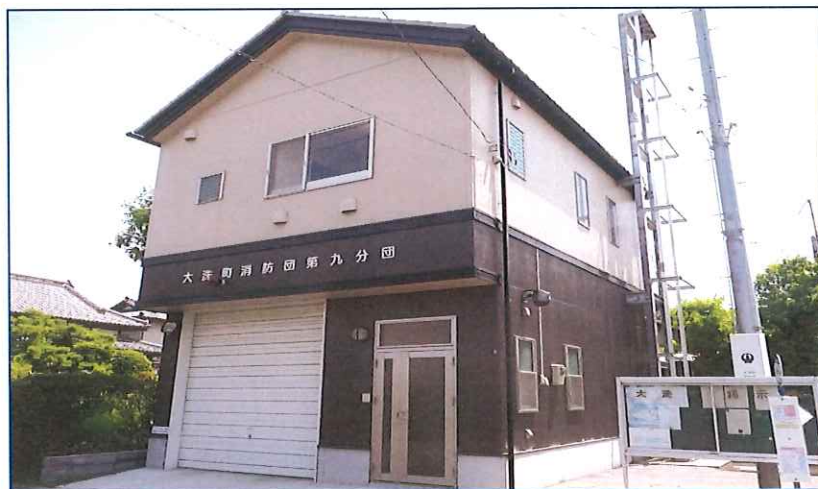
第九分団詰所 平成19年3月竣工
