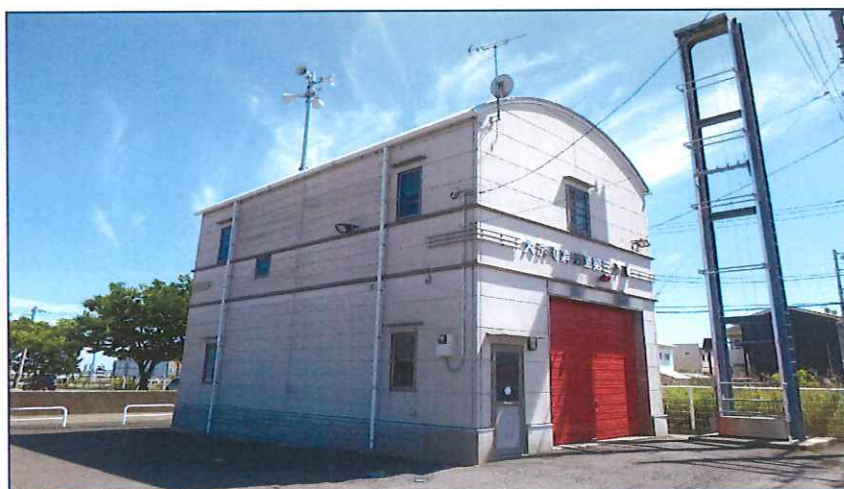
第三分団詰所 平成15年3月竣工
