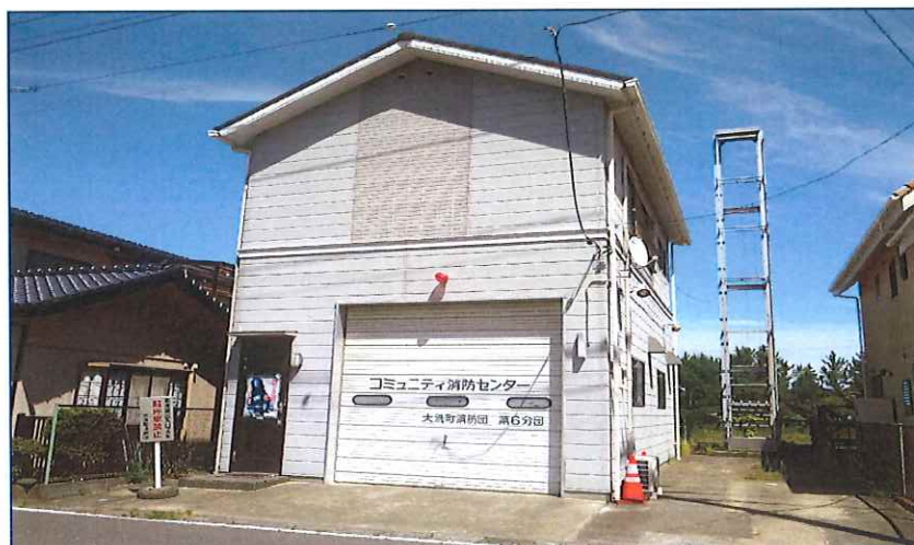
第六分団詰所 平成6年3月竣工
