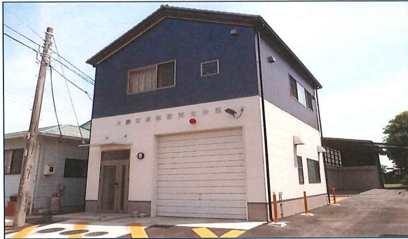
第七分団詰所 平成21年3月竣工
