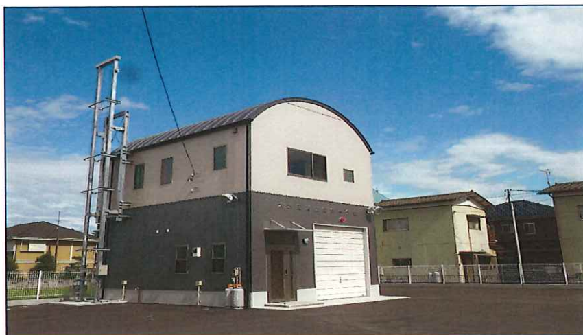
第一分団詰所 平成26年3月竣工
