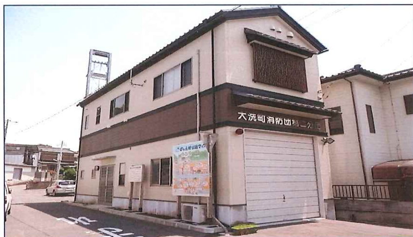
第二分団詰所 平成18年3月竣工
