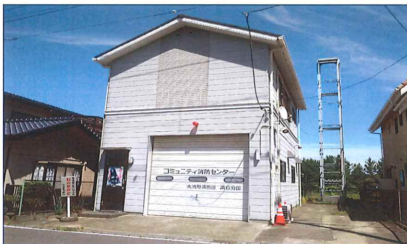
第六分団詰所 平成6年3月竣工
