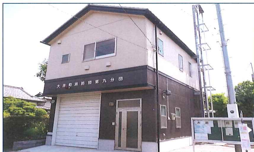
第九分団詰所 平成19年3月竣工
