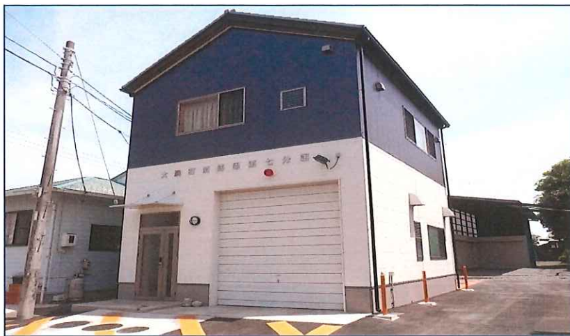
第七分団詰所 平成21年3月竣工
