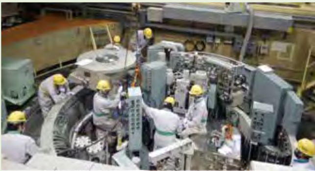
原子炉容器上に設置された装置の分解点検
