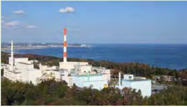
高速実験炉「常陽」 熱出力：10万KW（100 MW） 冷却材：ナトリウム 燃料：ウラン・プルトニウム混合酸化物
