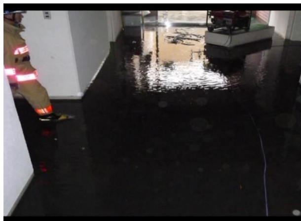
庁舎内浸水の様子
