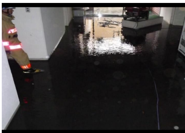
庁舎内浸水の様子
