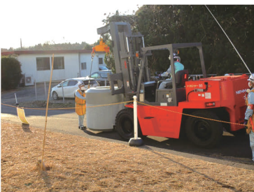
コンクリートブロックの配置
