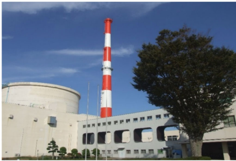
高速実験炉「常陽」
