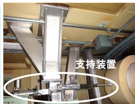
ナトリウム配管支持装置 の性能アップや追加 （耐震補強工事の一例）
