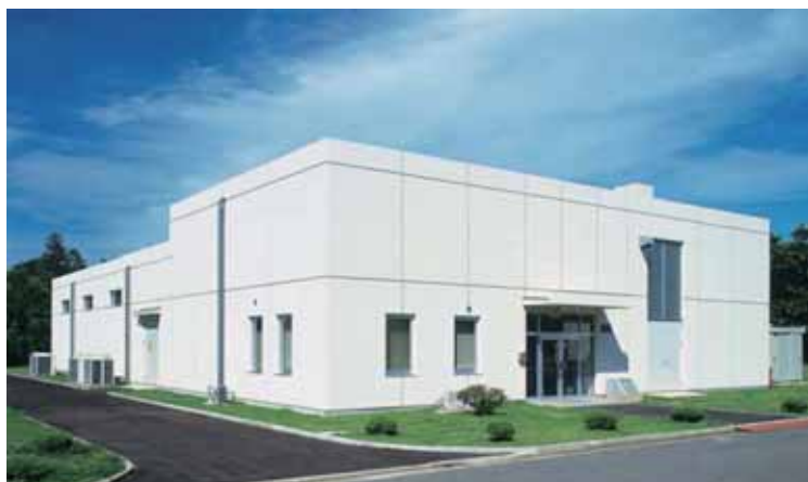
ウラン燃料研究棟外観
