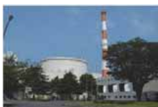
高速実験炉「常陽」
