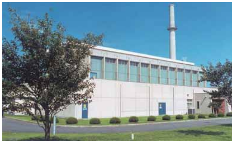
ホットラボ施設外観
