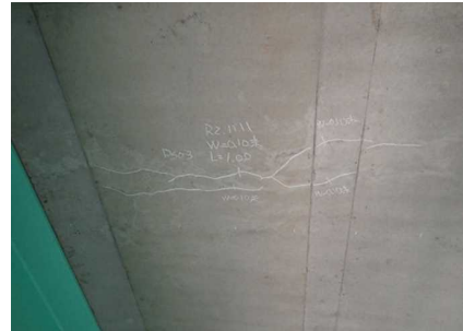
富士山橋:床版補修
