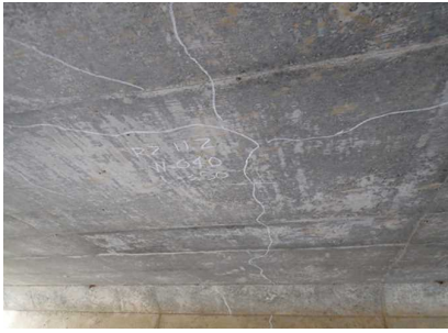
0005号橋:ひび割れ注入
