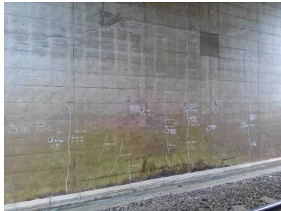
古宿道路橋:下部工補修
