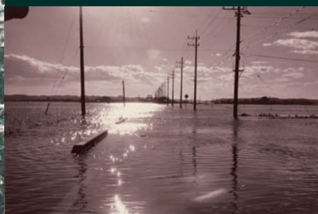
県道106号大貫橋付近
