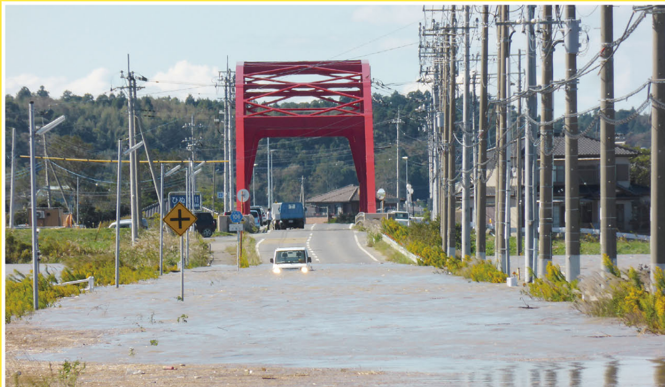
(R1.10.13 台風19号 大貫橋)
