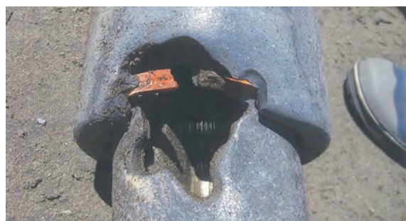
漏水した水道管破損の様子
