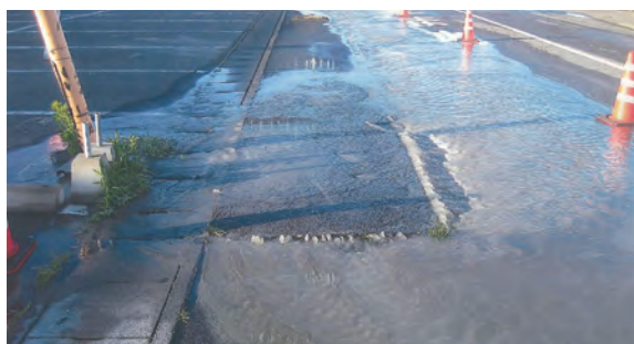
漏水場所の様子
