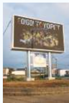
LED サイネージ設置
