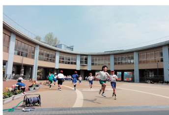
大洗小学校 いそはまプラザ
