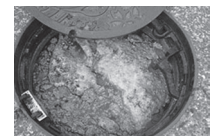
油脂類の堆積により閉塞したマンホール
