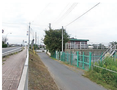
涸沼橋（平戸橋）付近。写真右のコンクリート構造物の近くを汚水が流れています。
