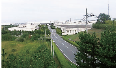
那珂久慈浄化センター
