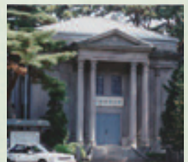
平成3年屋根改修後
