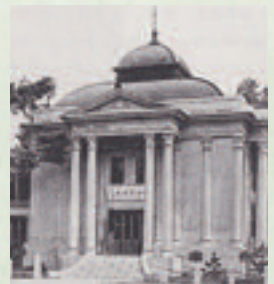
昭和4年建設当初
