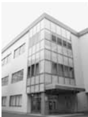
裁判員裁判棟の外観
