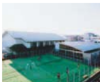
テニスコート、音楽室 武道場棟の全景
