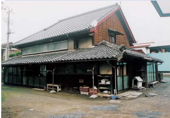
▲4面に庇の付く、切妻造の外観を残しています。
