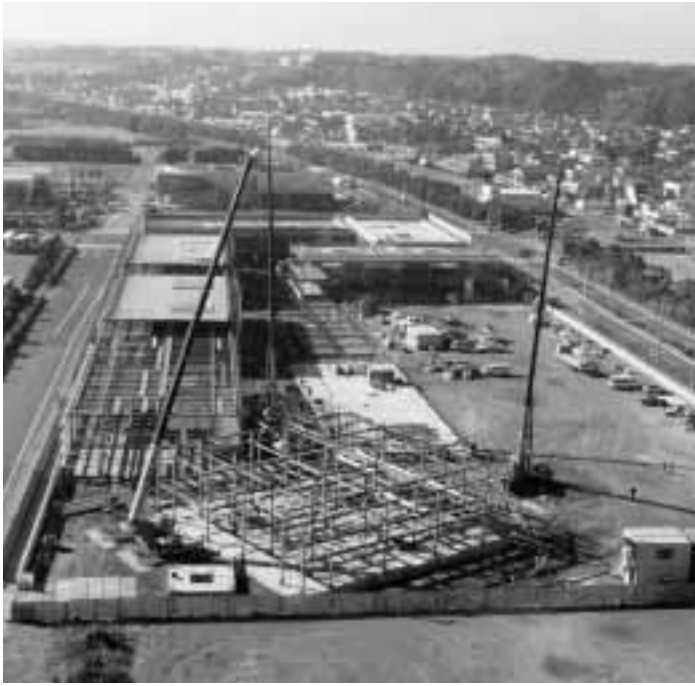
H18.3月オープンに向け、着々と建設が進むリゾートアウトレットモール
