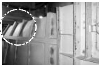
破裂の影響により変形したダクト部
