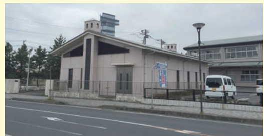
港中央中継ポンプ場(後方の建物はゆっくら健康館)
