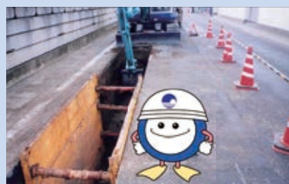
開削工法の例
