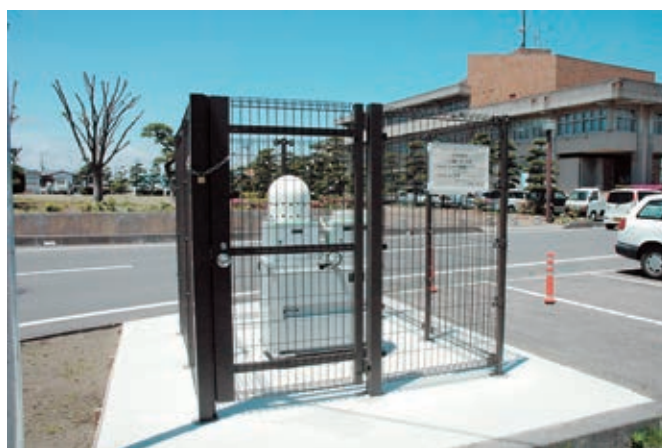
役場前の放射線測定局 (可搬型モニタリングポスト)
