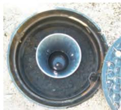
マンホールの内部には水が張られていて、汚物を下水道管へ流せるようになっています。
