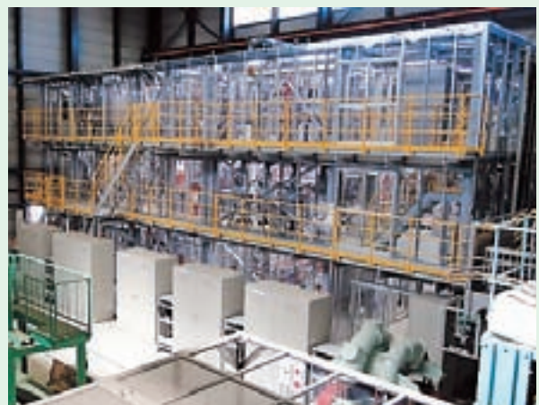
ISプロセス連続水素製造試験設備
