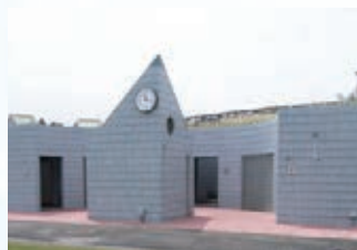
総合運動公園トイレ改修
