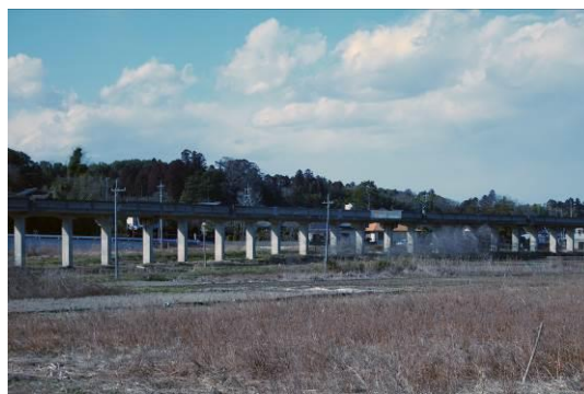
田園地帯を走る鹿島臨海鉄道大洗鹿島線の高架橋
