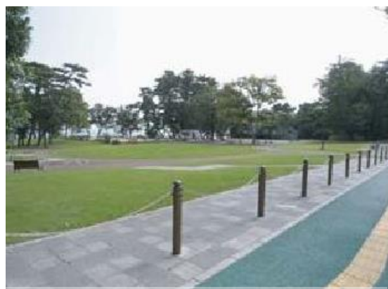
進入防止柵 道路照明と同様、洗練されたスタイル (事例は、さらに開放感を演出)
