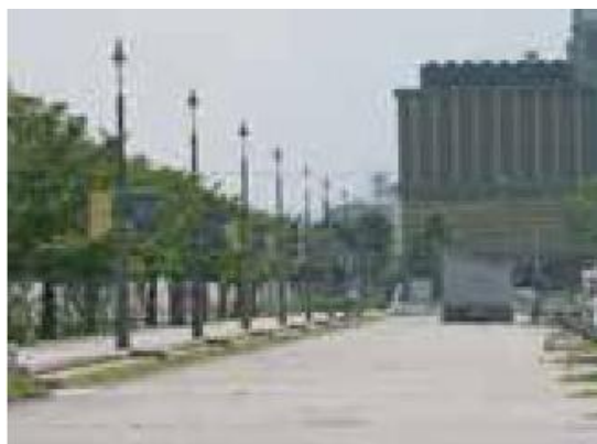
道路照明 洗練されたスタイルの道路照明 (統一されたデザインが同じ軸上に並ぶ)
