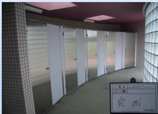
【工事完了後②】
