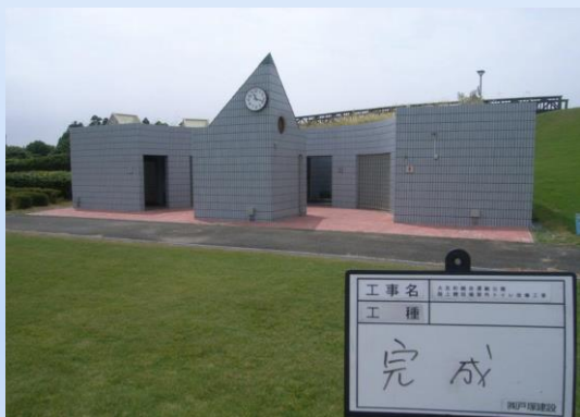
【工事完了後①】
