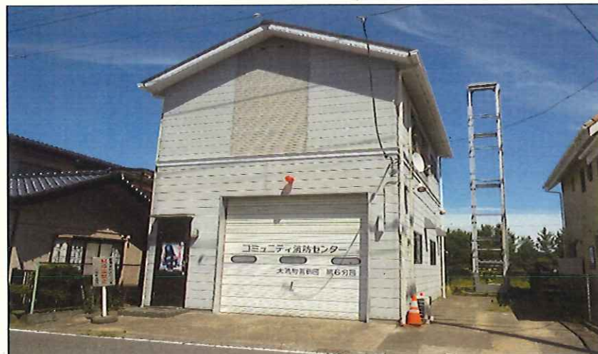
第六分団詰所 平成6年3月竣工
