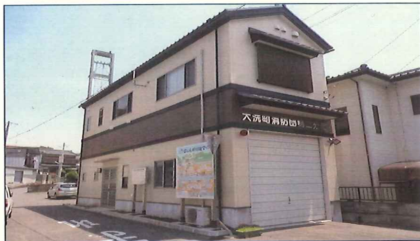
第二分団詰所 平成18年3月竣工
