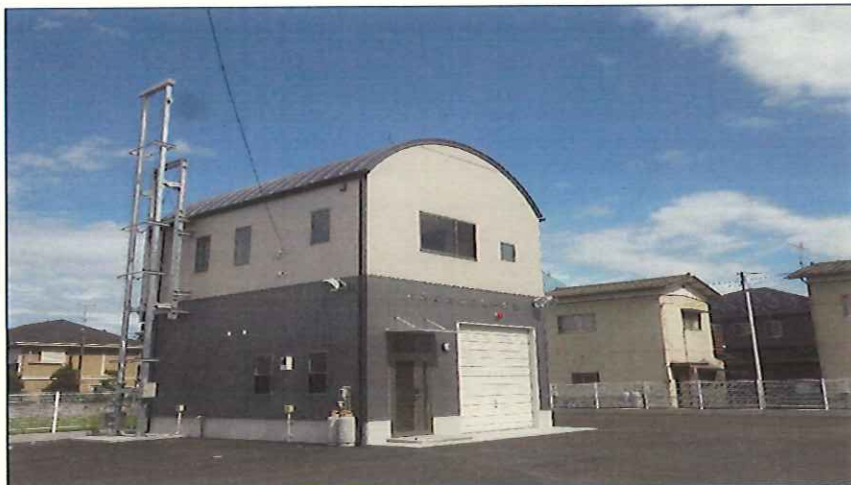
第一分団詰所 平成26年3月竣工
