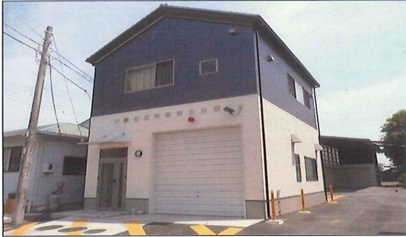
第七分団詰所 平成21年3月竣工
