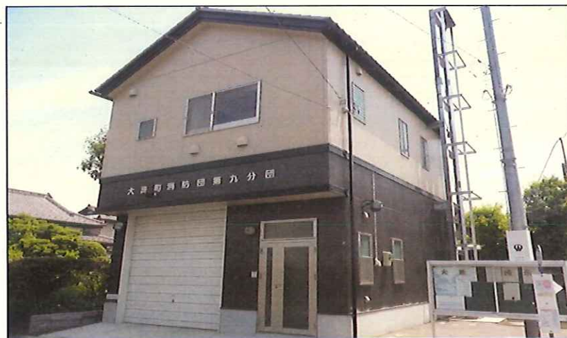
第九分団詰所 平成19年3月竣工
