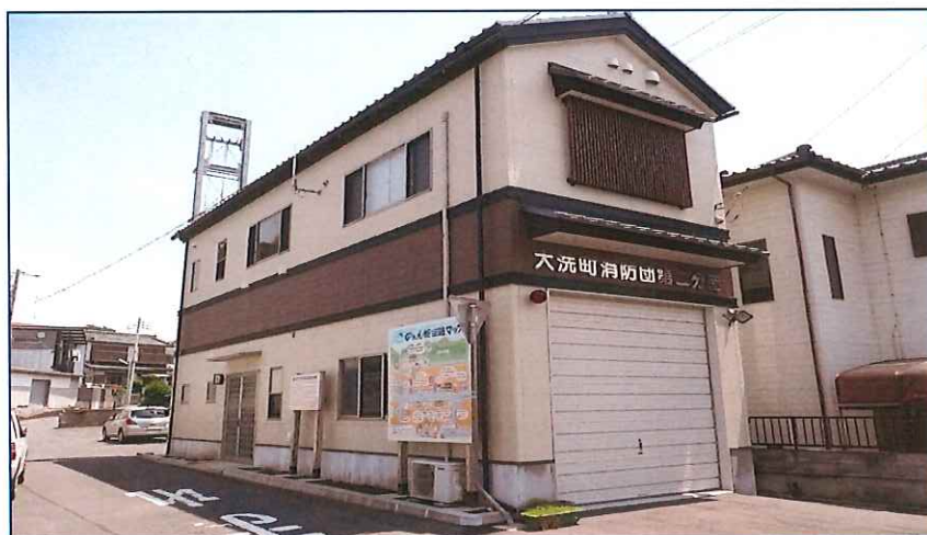
第二分団詰所 平成18年3月竣工
