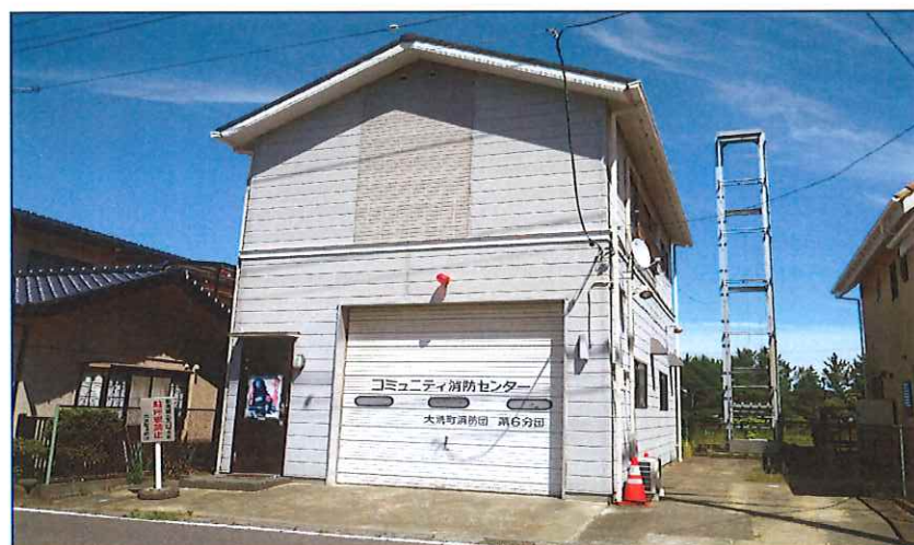
第六分団詰所 平成6年3月竣工
