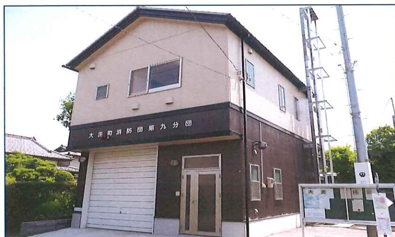
第九分団詰所 平成19年3月竣工
