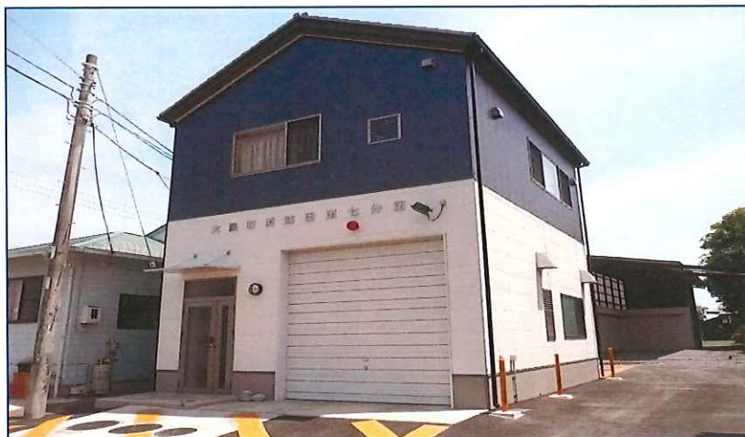
第七分団詰所 平成21年3月竣工
