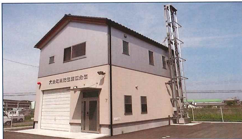
第四分団詰所 平成20年3月竣工
