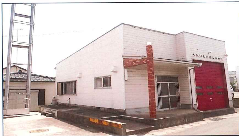
第五分団詰所 昭和59年11月竣工
