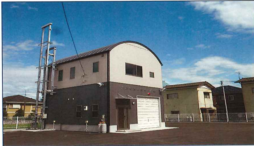
第一分団詰所 平成26年3月竣工
