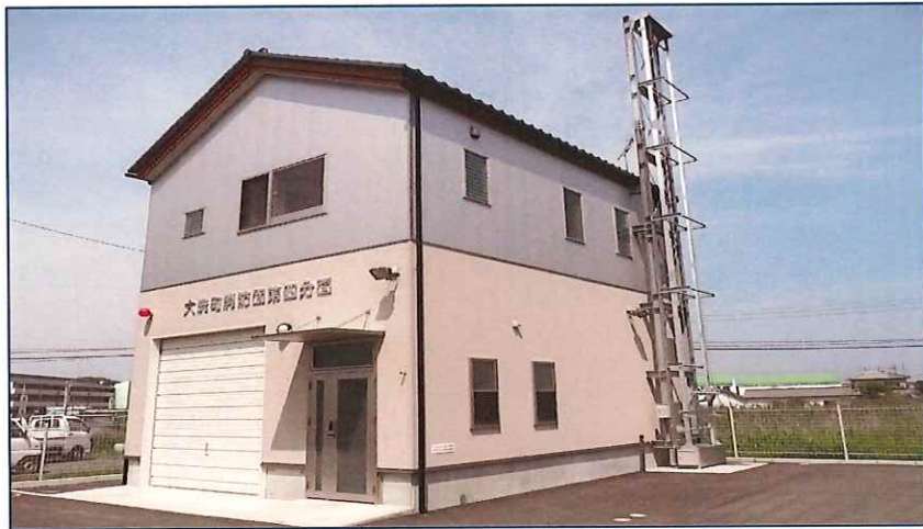
第四分団詰所 平成20年3月竣工
