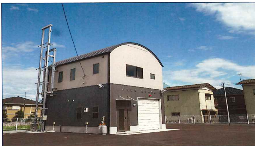
第一分団詰所 平成26年3月竣工
