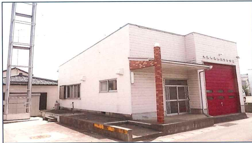
第五分団詰所 昭和59年11月竣工
